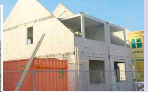
Het betonnen casco is gereed.
