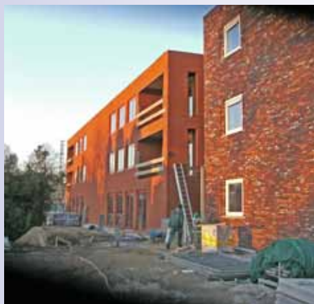
Kopgevel blok B en achtergevel blok F.
