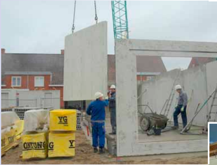
De montage van het casco door Heembeton.
