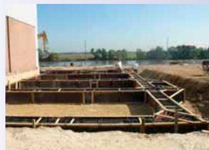
De fundering voor het kantoor.
