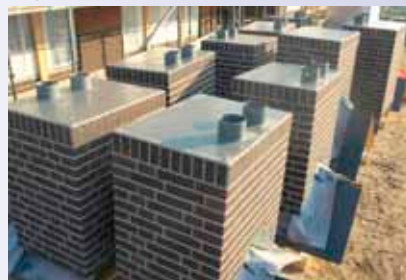
De prefab schoorsteen.
