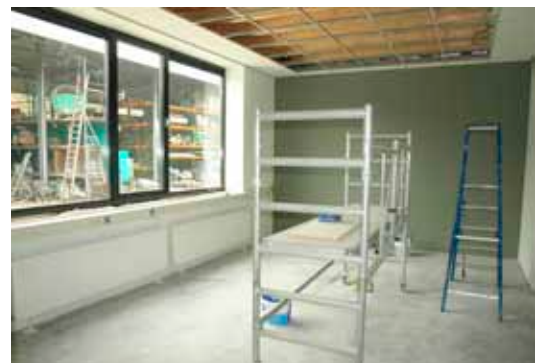
Kantoor aan de achterzijde met zicht op de werf. Hier komen Gé van Soest en Jan Vullings te zitten.
