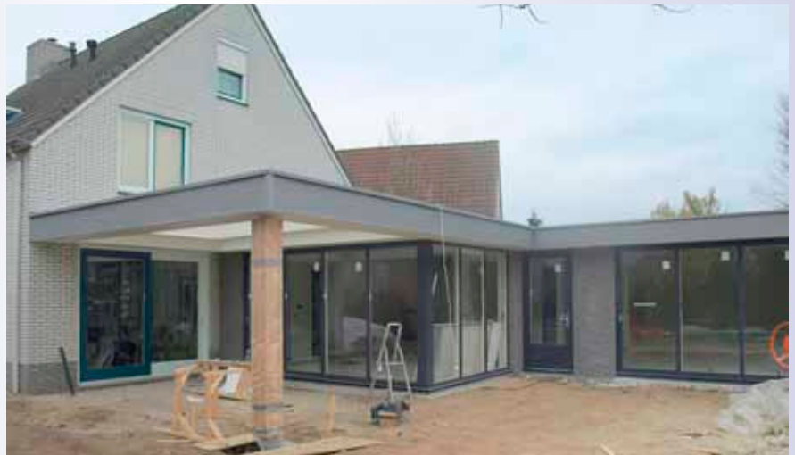
Uitbreiding Reigersbek 11, links de overkapping met louvredak.
