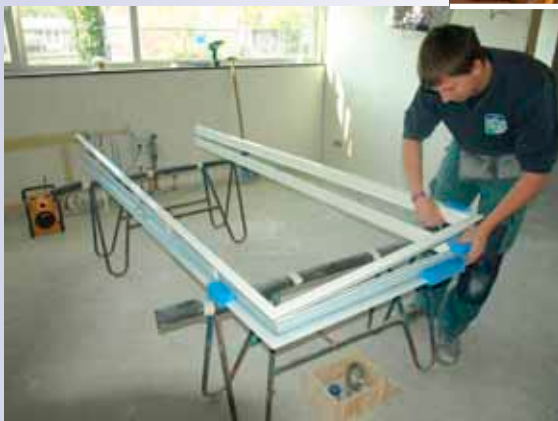
Een deel van het kozijn is voorzien van lipjes, waarmee dit kozijndeel in de kozijnsparing wordt vastgezet.
