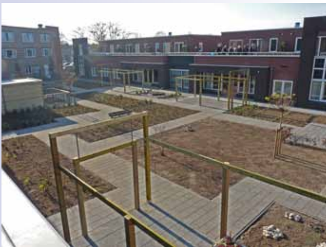
De binnentuin van het nieuwe complex.
